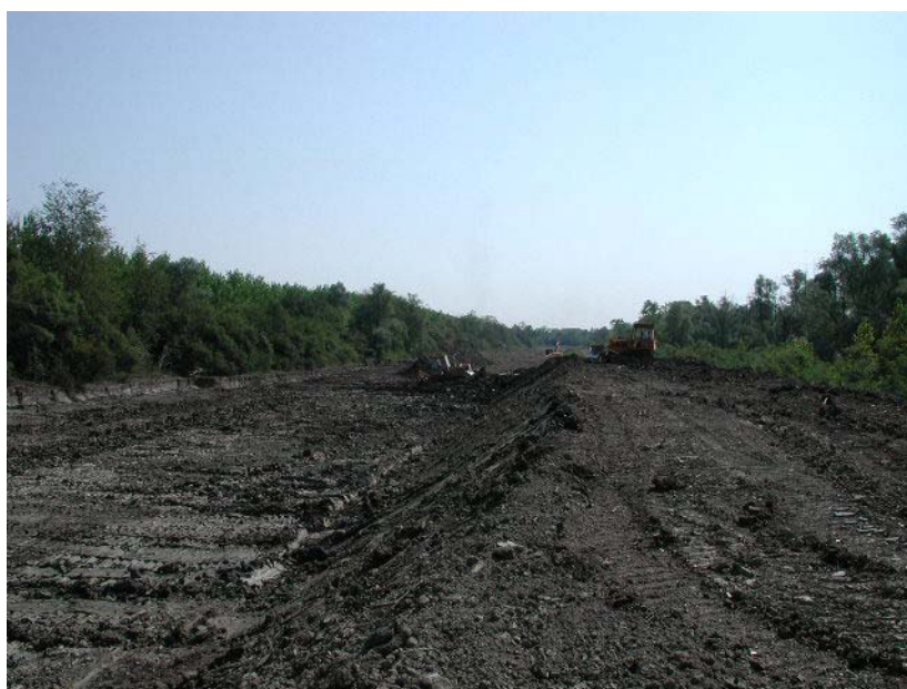
Fig. 3 – Lavori in corso per il sovrizzo dell'arginatura in sinistra Canale Emissario (Fonte: Consorzio della Bonifica Renana).
