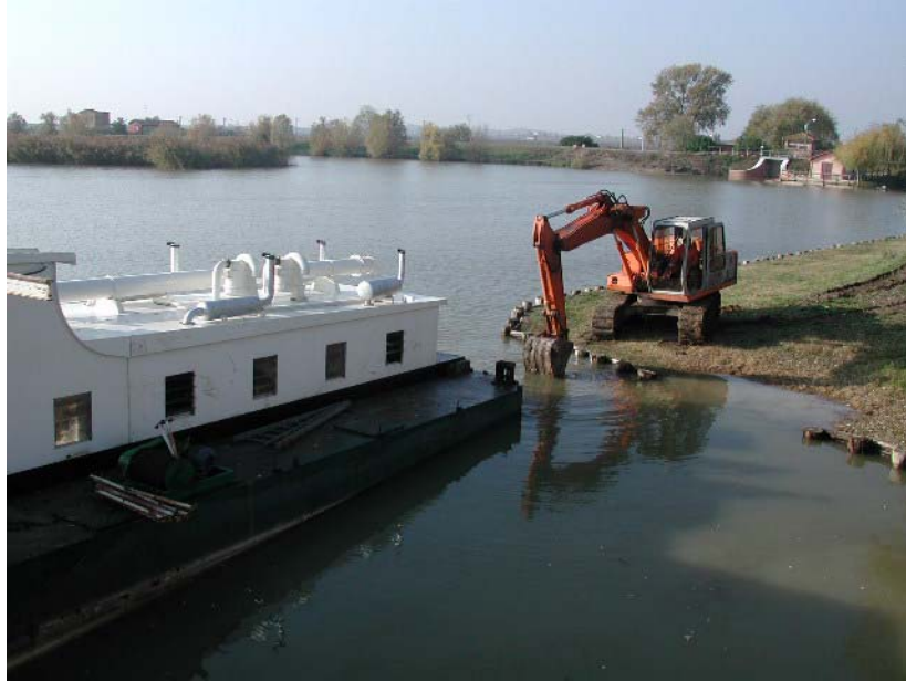
Fig. 1 – Ammaraggio della draga (Fonte: Consorzio della Bonifica Renana).
