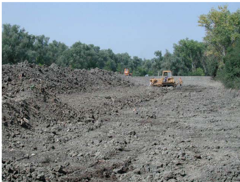
Fig. 2 – Lavori in corso per il sovrizzo dell'arginatura in sinistra Canale Emissario (Fonte: Consorzio della Bonifica Renana).
