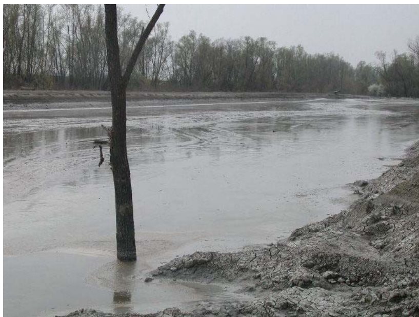
Fig. 4 – Sovralzo dell'arginatura in sinistra Canale Emissario e deposito del materiale dragato (Fonte: Consorzio della Bonifica Renana).
