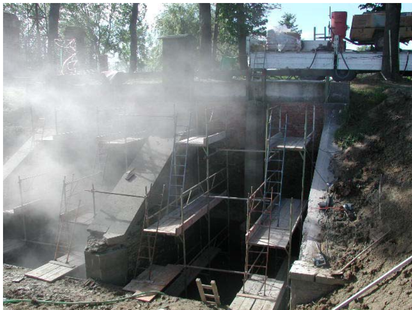
Fig. 7 – Ponteggi e impalcature per la realizzazione degli interventi (Fonte: Consorzio della Bonifica Renana).
