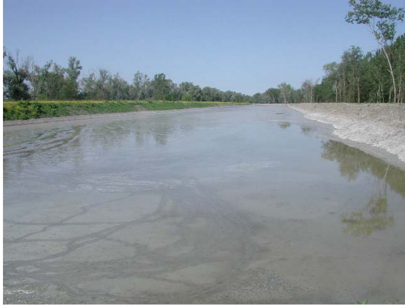
Fig. 5 – Sovralzo dell'arginatura in sinistra Canale Emissario e deposito del materiale dragato (Fonte: Consorzio della Bonifica Renana).
