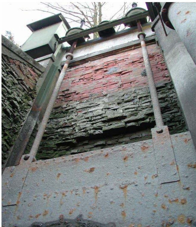
Fig. 8 – Dettaglio di paratoia e muratura oggetto d'intervento (Fonte: Consorzio della Bonifica Renana).
