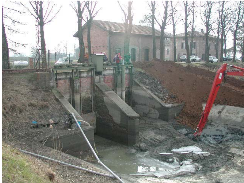
Fig. 6 – Lavori di scavo propedeutici alla realizzazione degli interventi (Fonte: Consorzio della Bonifica Renana).
