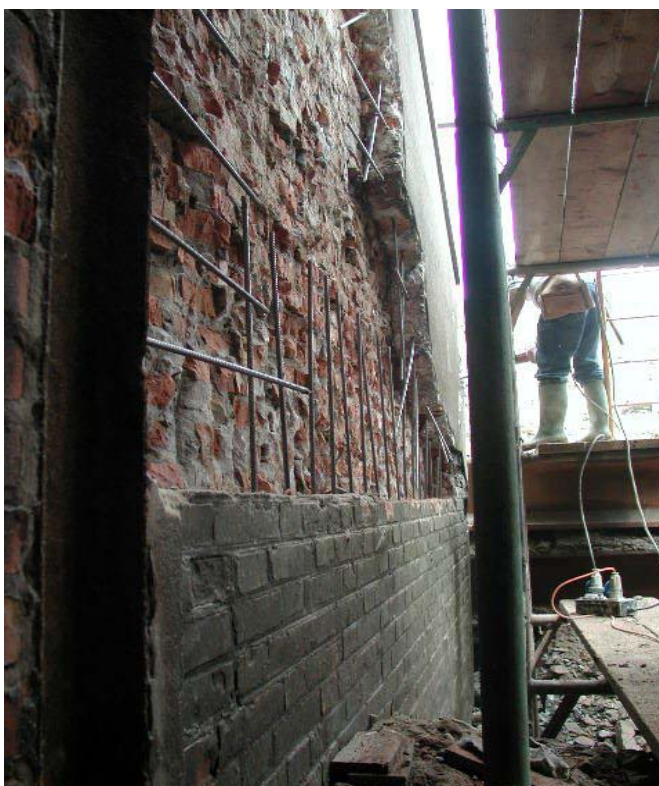
Fig. 9 – Lavori di ripristino delle murature (Fonte: Consorzio della Bonifica Renana).
