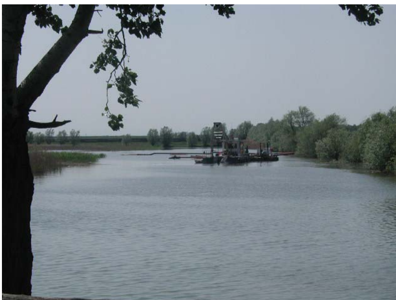
Fig. 2 – Lavori di dragaggio (Fonte: Consorzio della Bonifica Renana).
