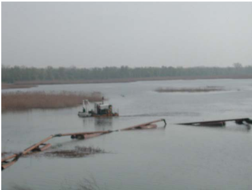
Fig. 1 – Lavori di dragaggio (Fonte: Consorzio della Bonifica Renana).
