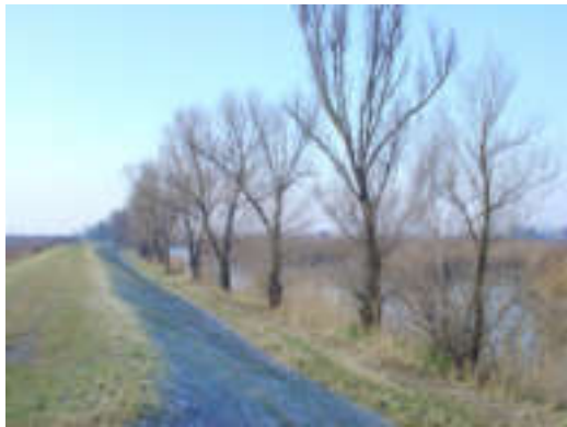
Fig. 33. Filare di salici lungo cassa Valle Santa, 2005.
